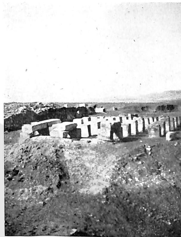
Timgad - Travaux de surélévation de la voie menant à LAMBESE
