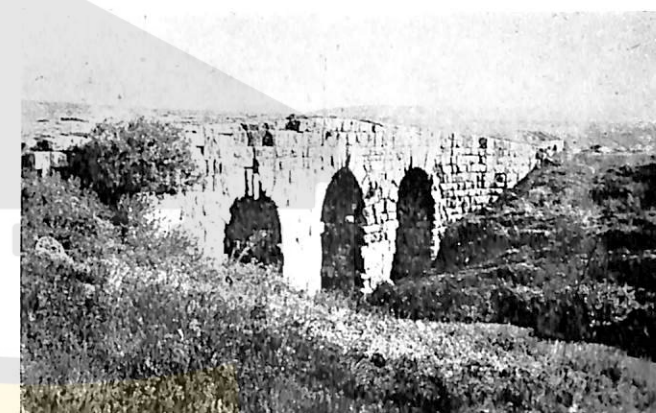
Cliché Musée Alaoui, Tunis Le plus ancien pont daté de l'Afrique romaine construit sous TIBERE en 29-30, il traversait l'Oued Béja au Sud de la ville de VAGA (Béja, Tunisie)
